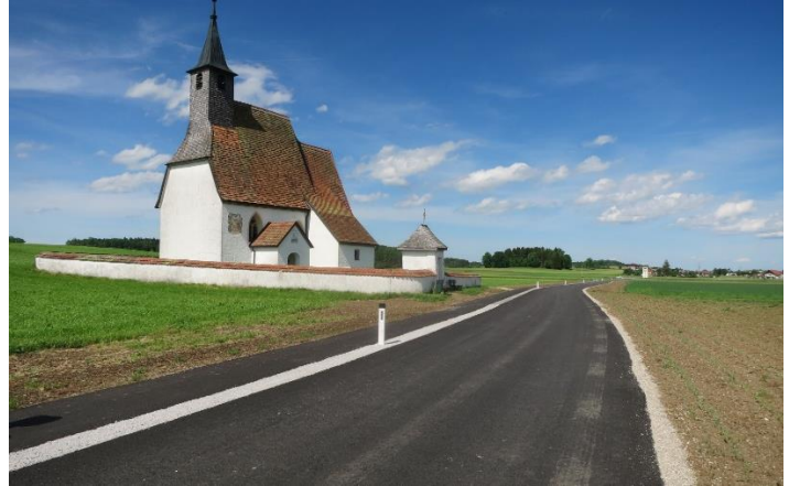
.... und im Mai nach der Fertigstellung.
