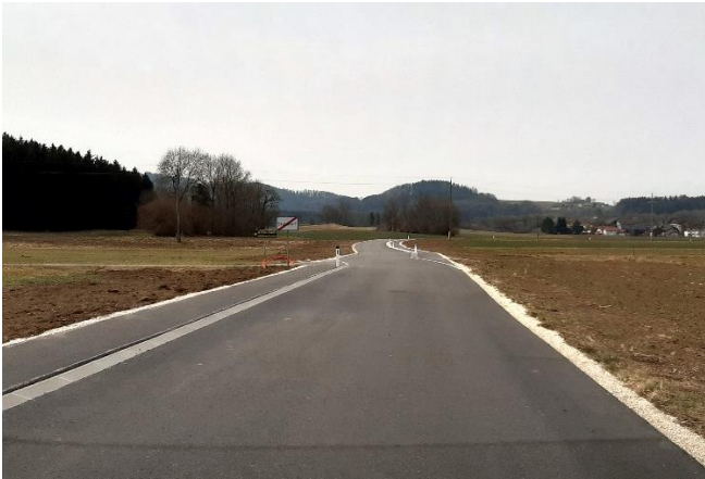
Baustelle Kematingerstraße im März ....
